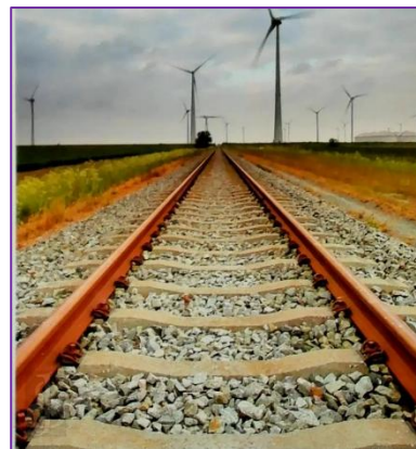
Zonder dwarsliggers geen spoor.
